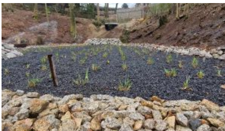
Umělý vertikální mokřad s funkcí kořenové čistírny v Zoo Liberec.
